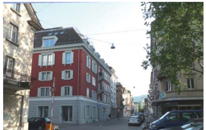
Energetisch sanierter Altbau der Wogeno, Zürich
