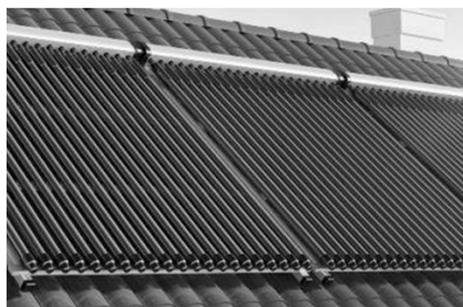
Solarthermie - Röhrenkollektor
