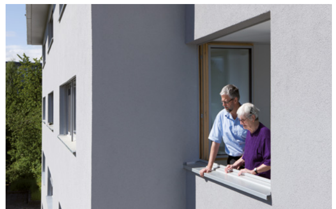
Mehr Wohnlichkeit und weniger Energieverbrauch dank neuer Fenster und einer gedämmten Fassade.
