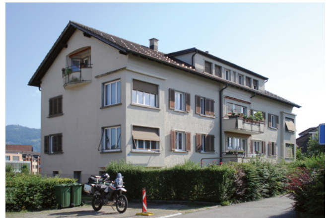
Vor einer Sanierung der Aussenhülle...
