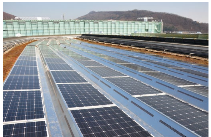
Solaranlage auf Flachdach
