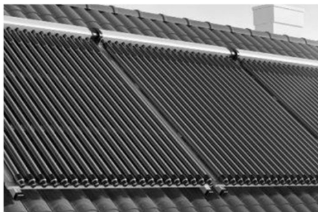
Solarthermie - Röhrenkollektor
